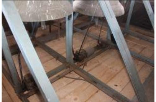
**Eigentlich eine Kleinigkeit:** In der Glockenstube sollte nur der Fußboden aus Sicherheitsgründen ausgetauscht werden. Doch sehr spät wurde klar, dass die Läuteanlage in einem Zustand ist, der einen Austausch unumgänglich macht. So lange schweigen die Glocken hauptsächlich weiter, auch wenn eine zwischenzeitliche Lösung fürs manuelle Läuten gefunden werden konnte.
