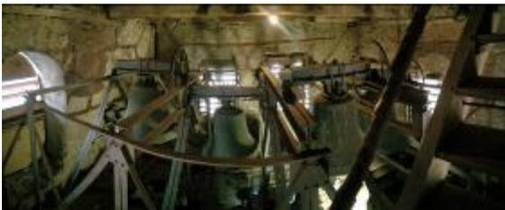
Hier konzentriert sich die Maßnahme für die das Kirchgeld 2018 gesammelt wird: Die Glockenstube in Westuffeln. Die neue Glockensteuerung ist schon eingebaut. Die sind Schallluken abgängig. Zudem ist am linken Bildrand der überschaubar große Zugang zum Kirchenschiffboden zu sehen. Hinzu kommen Elektroarbeiten und die Instandsetzung bzw. Austausch der Eingangstüren. Insgesamt sind 55.000 Euro veranschlagt.
